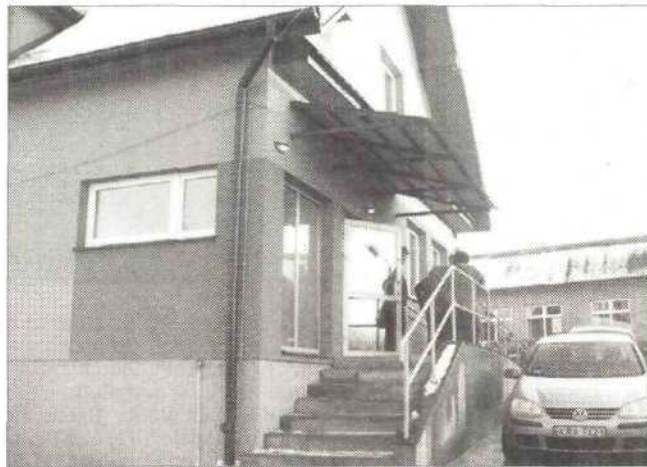
W ramach „Equala” w zeszłym roku w BUK-u w Gaju wyremontowano stary budynek
