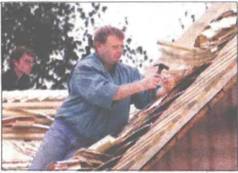
Nauka krycia dachu metodami tradycyjnymi
