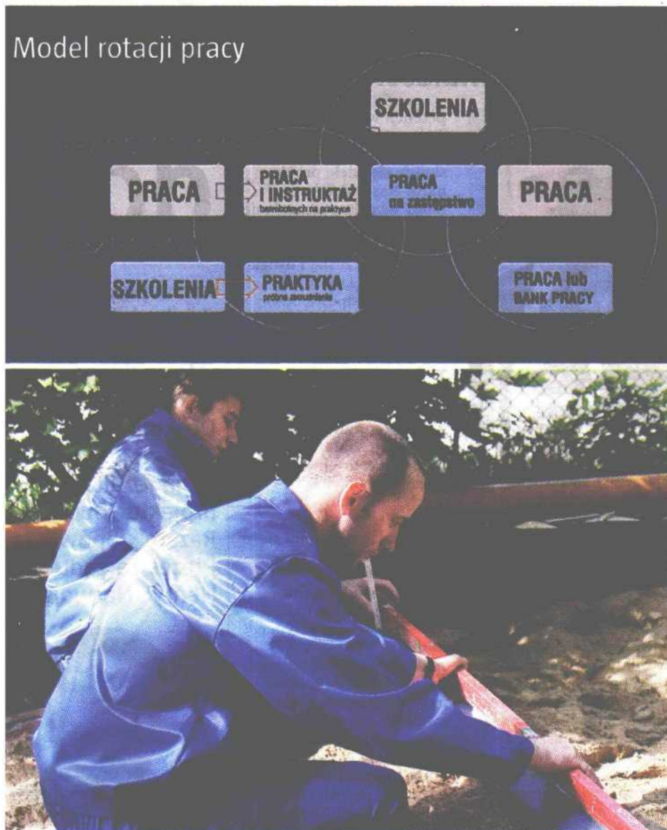
Szkolenie w Centrum Budowlanym przy ul. Gietkowskiej Fot. W-M ZDZ w Olsztynie
