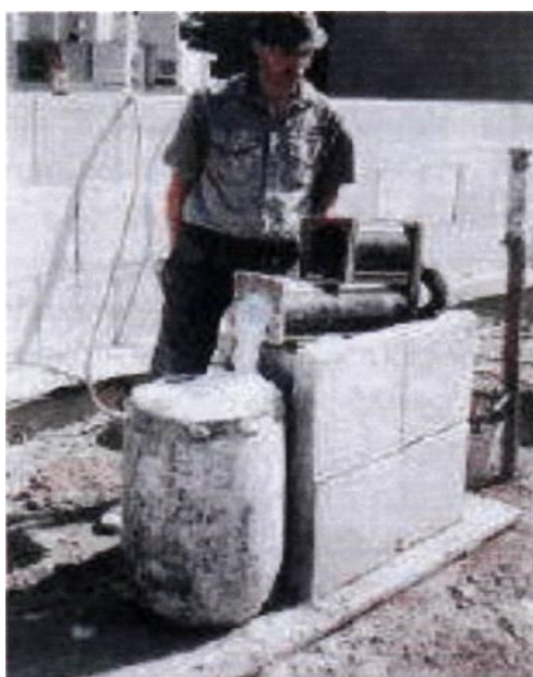
Fot.6.3. W systemie SOVA materiałem ocieplającym ścianę jest pianogips.
