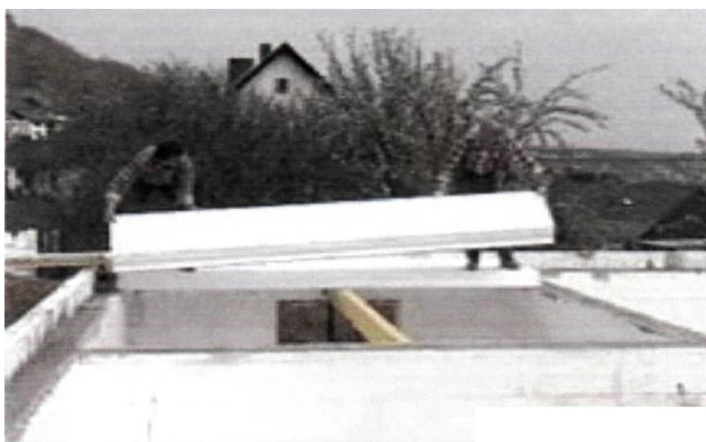
Fot. 10.11 Układanie stropu nad kondygnacją parteru
