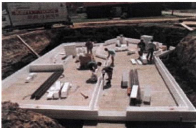
Fot. 10.5 Montaż drugiej warstwy kształtek na płycie fundamentowej
