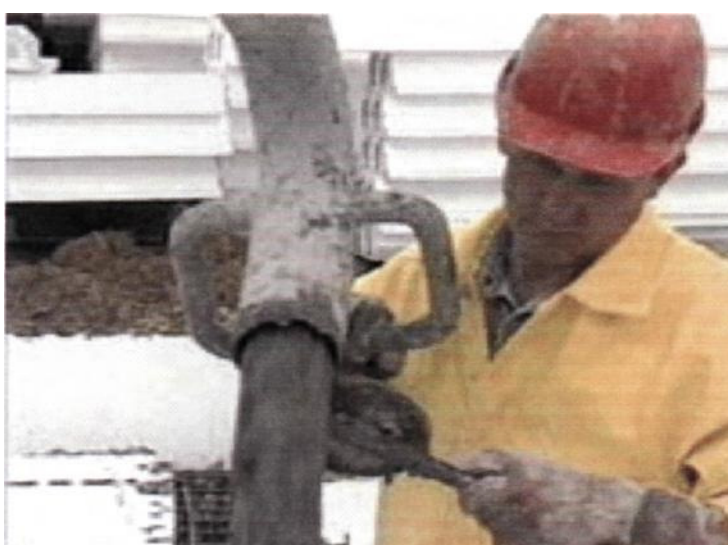
Fot. 10.9 Betonowanie konstrukcji szalunku
