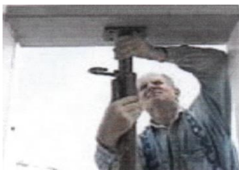
Fot. 10.8 Podpieranie nadproża okiennego przed zabetonowaniem
