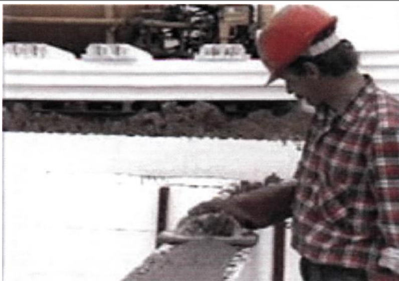
Fot. 10.10 Wygładzanie betonu
