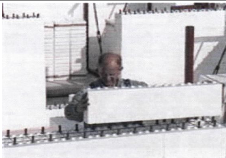
Fot. 10.7 Nakładanie elementu ściany
