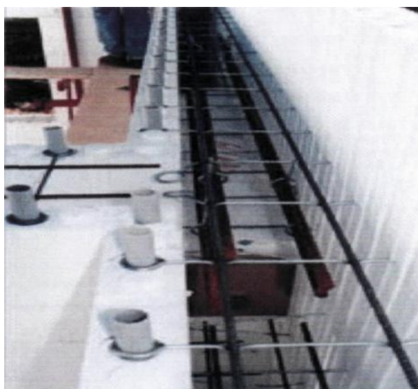
Fot. 10.6 Wnętrze szalunku ściany zewnętrznej, zabudowana kasetka żaluzyjna ze zbrojeniem nadproża okiennego
